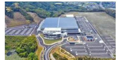
新本社工場の空撮図 新本社工場はこれまでの約9倍となる13.5万㎡の広大な北九州小倉地区の敷地に、本社、工場棟、金型棟、R&D棟、保育園を配置
