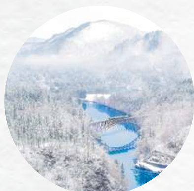
第一只見川橋梁・只見線（福島県）
